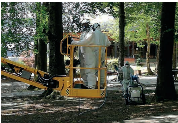
Figure 34. Des agents intégralement protégés prêts à intervenir (Dominique Dechambre, ONF)
