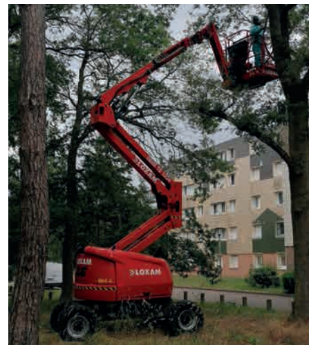
Figure 38. Comme pour les interventions sur chenilles, l'utilisation d'une nacelle permet d'atteindre les nids/plaques situés les plus en hauteur comme ici pour cette intervention de destruction par aspiration (FREDON Normandie)
