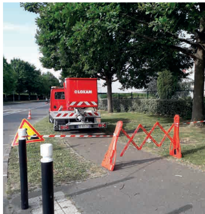
Figure 27. Pour limiter les risques pour les usagers du site, la zone d'intervention doit être balisée et son accès interdit (Antoine Kaniewski, Saint Quentin en Yvelines)
